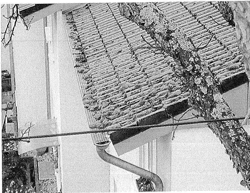
Baum 1: Blick von der Krone auf das Nachbarhaus 2b; Vermoosung durch Überschattung
