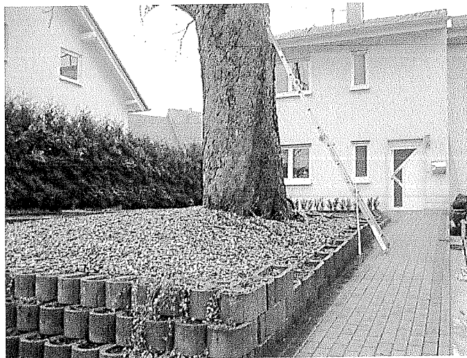
Baum 2: der Bereich der Wurzelplatte wurde abgegraben, das Gelände gepflastert und verfüllt
