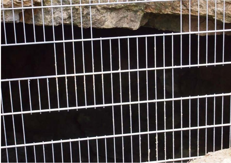
**Abb. 1: Ungeeignete Vergitterung des Stolleneingangs am ehemaligen Kalkbergwerk Hemmersdorf. Foto: C. Harbusch**
