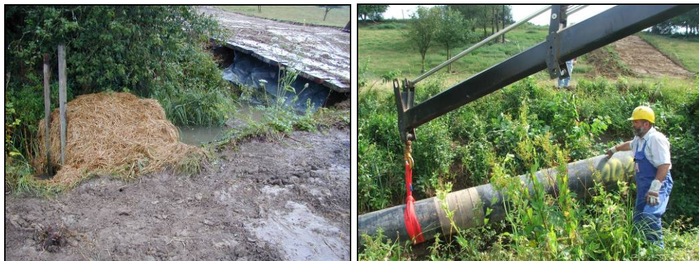
Abbildung 2: Strohfilter kurz unterhalb der Querungsstelle (links) und Einbringung des Stahlrohres für die Verdohlung (rechts).
