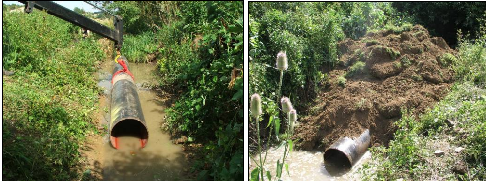
Abbildung 3: Lage des Verdohlungsrohres auf dem vorbereiteten Gewässerbett (links) und das mit Aushubmaterial überlagerte Rohr.
