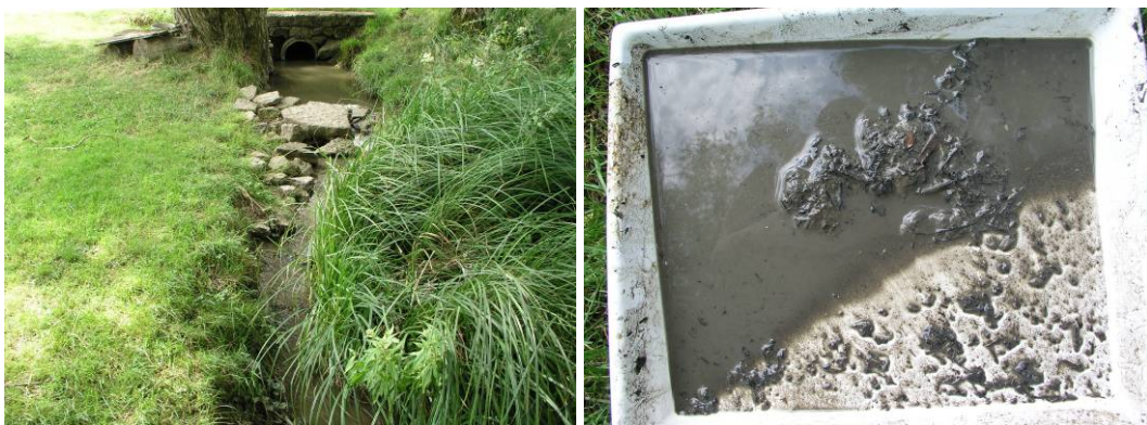
Abbildung 6: links: Gewässerverlauf im oberen Bereich von H1. rechts: Feinsedimentauflage von der Gewässersohle.
