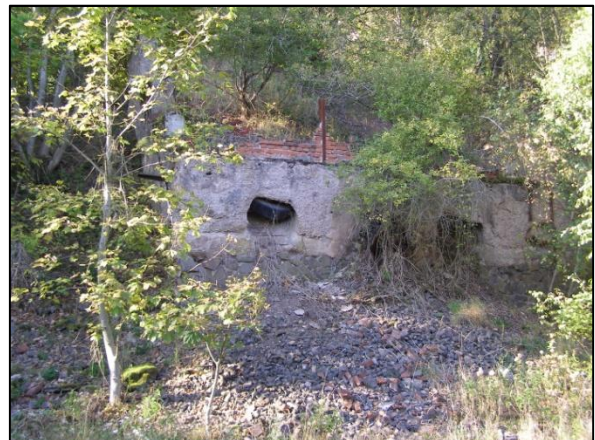
Foto 32: Gebäudereste der ehemaligen Verladeeinrichtung am südlichen Steinbruch
