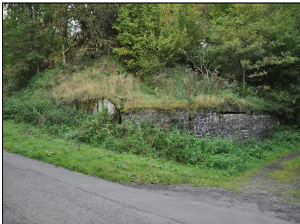
Foto 31: Mauer der ehemaligen Sortier- und Verladeanlage am nördlichen Steinbruch
