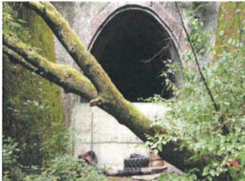
Abb. 3 u.4: Eingang West (Biringen) des Tunnels
