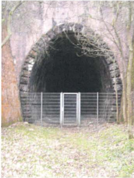
Abb. 1: Eingang Ost (Silwingen) des Tunnels
