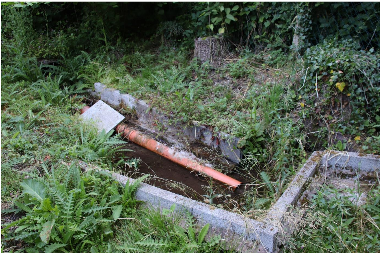
Foto 9: Verrohrung und Fassung eines Bachabschnitts im Quellenbereich des Klapperbergbachs. R.Nikolei, 15.06.2023.
