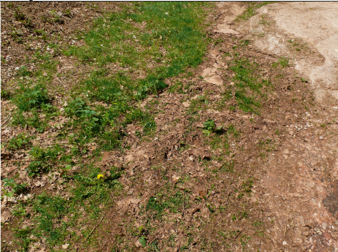
Abb. 3: Regenwasserabfluss entlang des Weges mit eutrophierender Wirkung (siehe Maßnahme M-LRT-EH4)
