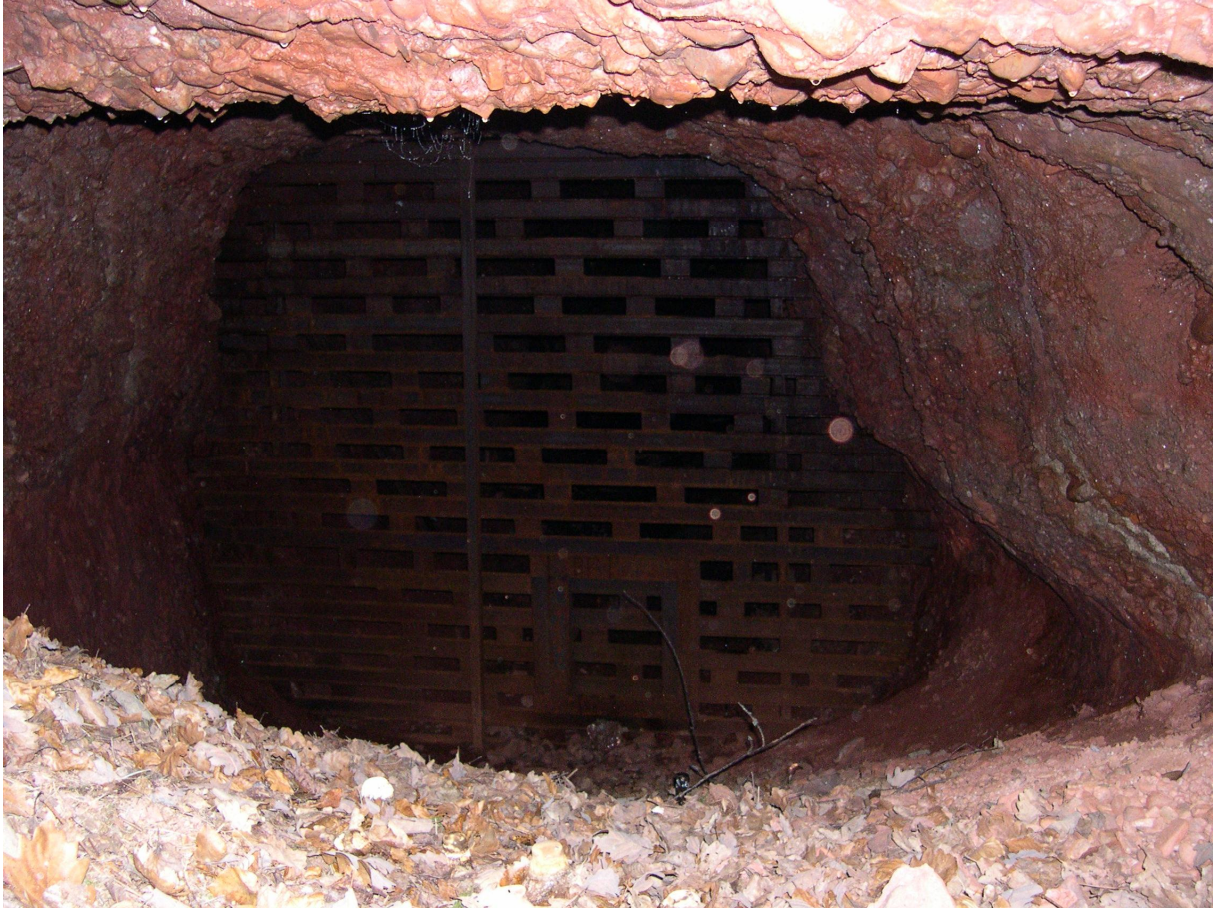
Abb. 1: Gittertür des Stollen 1 Hoxberg Foto: C. Harbusch, Januar 2005
