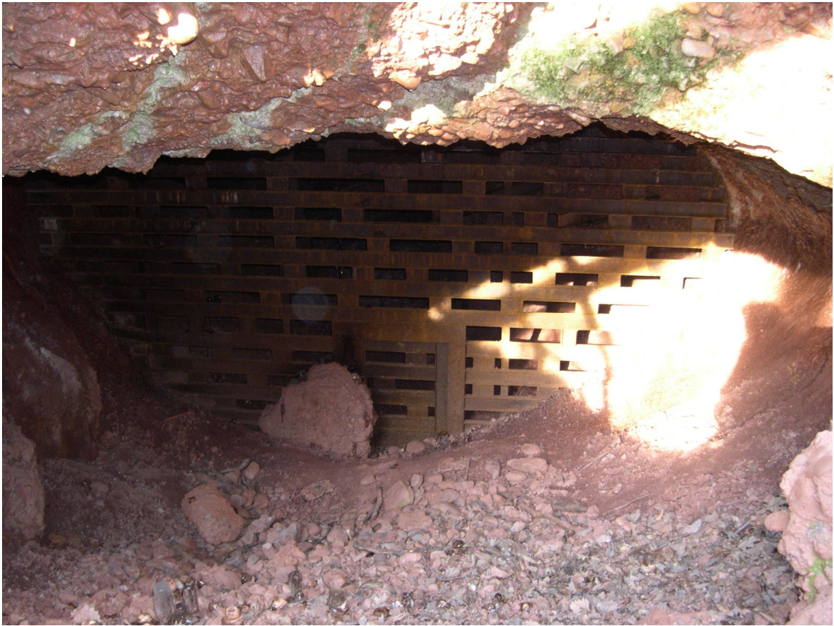
Abb. 2: Gittertür des Stollens 2 Hoxberg Foto: C. Harbusch, Januar 2005
