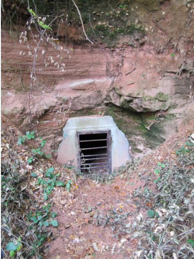
Abb.1: Gittertür am Stollen Eichelscheidt Foto: D. Gerber
