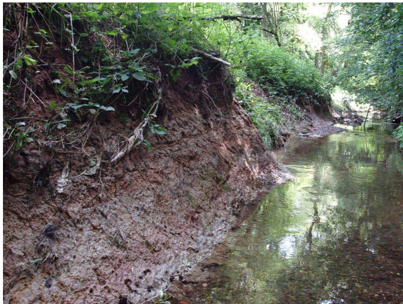
Abb. 17: Uferabbrüche des Bommersbaches im Bereich der Freizeiteinrichtungen als wahrscheinliches Bruthabitat des Eisvogels
